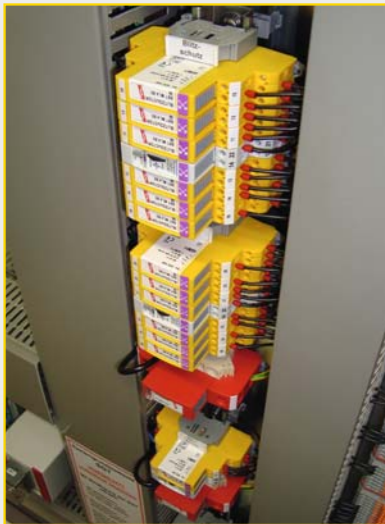
BLITZDUCTOR® XT ML BE 36 mit Condition Monitoring DRC MCM XT. Einsatz am Kabelabschlussgestell bei Bahnübergangssicherungsanlagen. with DRC MCM XT condition monitoring system. For use in cable termination racks at level crossing protection systems.
